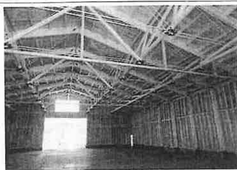
建築中の木造倉庫
